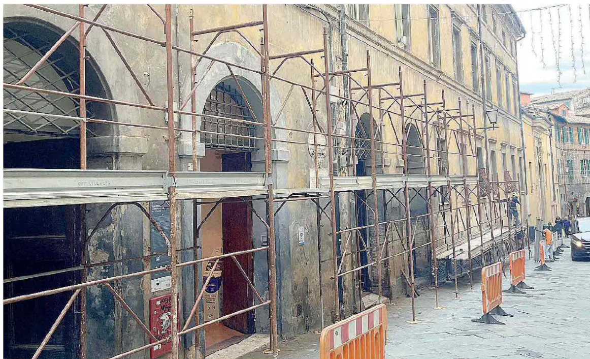
Il cantiere Lavori da 2.5 milioni al Palazzo della Sapienza sede della biblioteca degli Intronati
