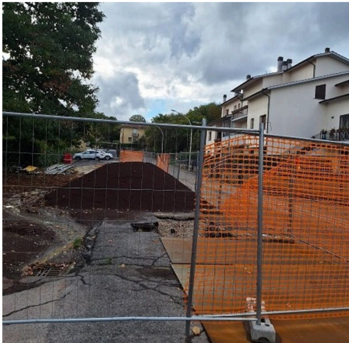
I lavori di realizzazione degli ultimi lotti del teleriscaldamento geotermico
